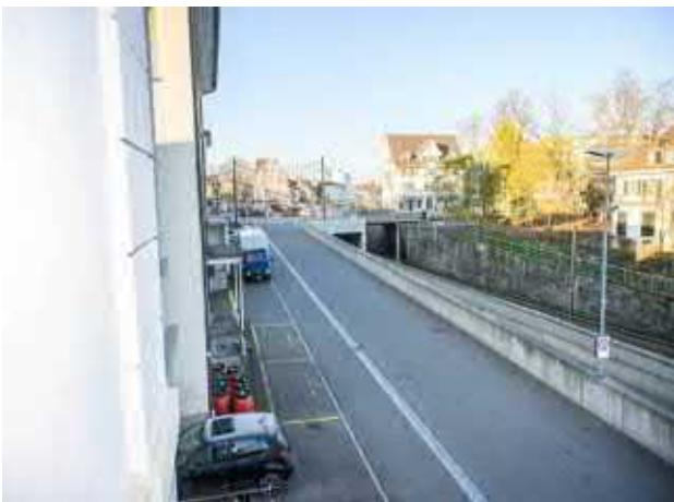
Hafenstr. 6: Situation Hafenstrasse gegen Westen
