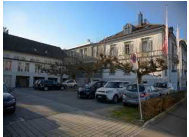
Hafenstr. 6/8: Ansicht Innenhof Nordost
