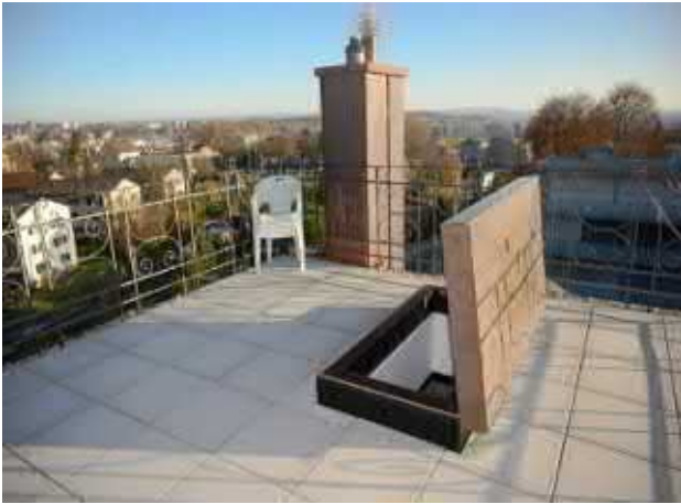
Hafenstr. 6: Ansicht Dachterrasse
