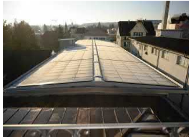
Bodanstr. 7a: Dachaufsicht
