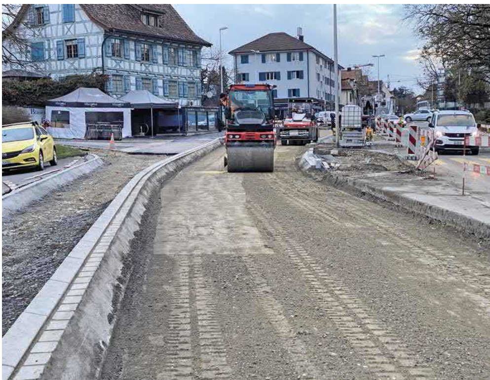
An der Romanshonerstrasse wird beim Blauen Haus die Planie erstellt.
