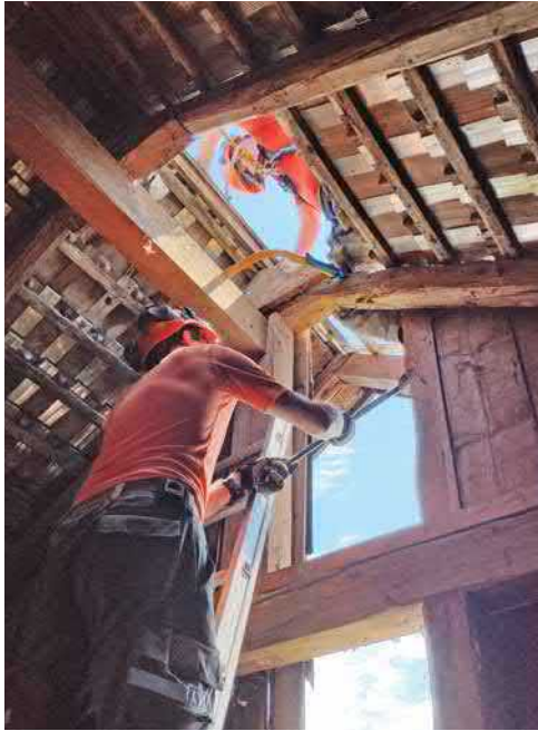
Dachdurchbruch für die Erstellung einer Absturzsicherung.
