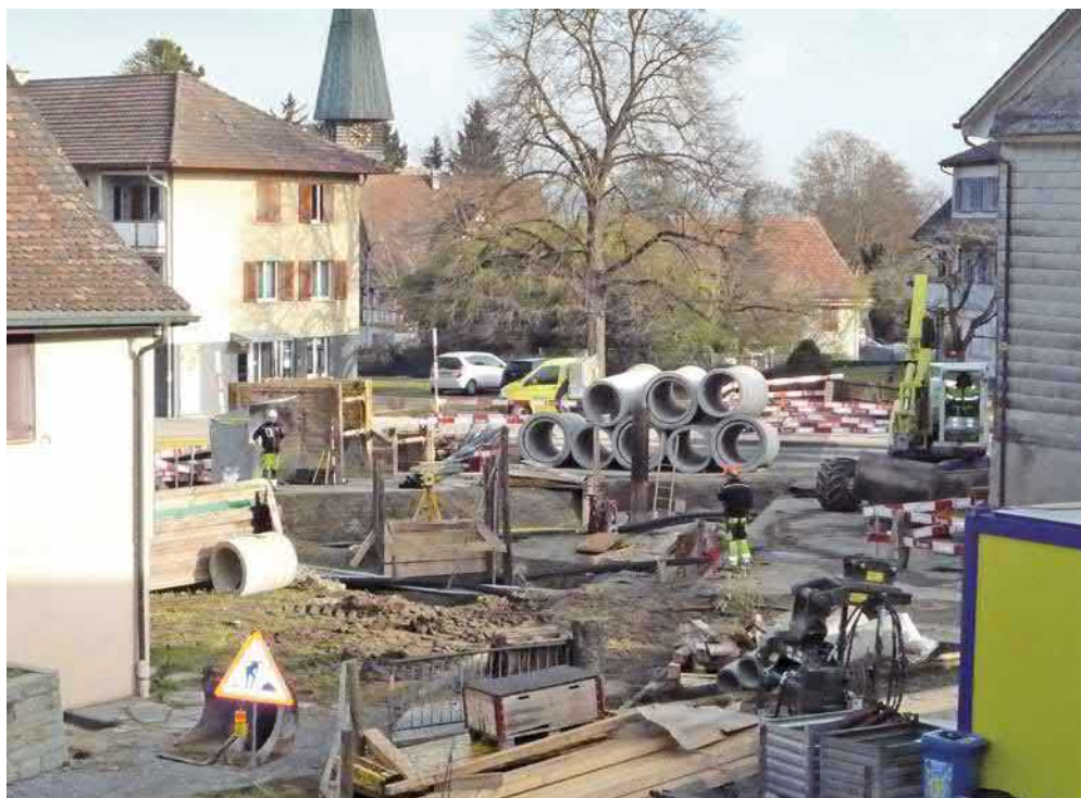
Neubau Durchlass Chogenbach im Dorfzentrum Kurzrickenbach.
