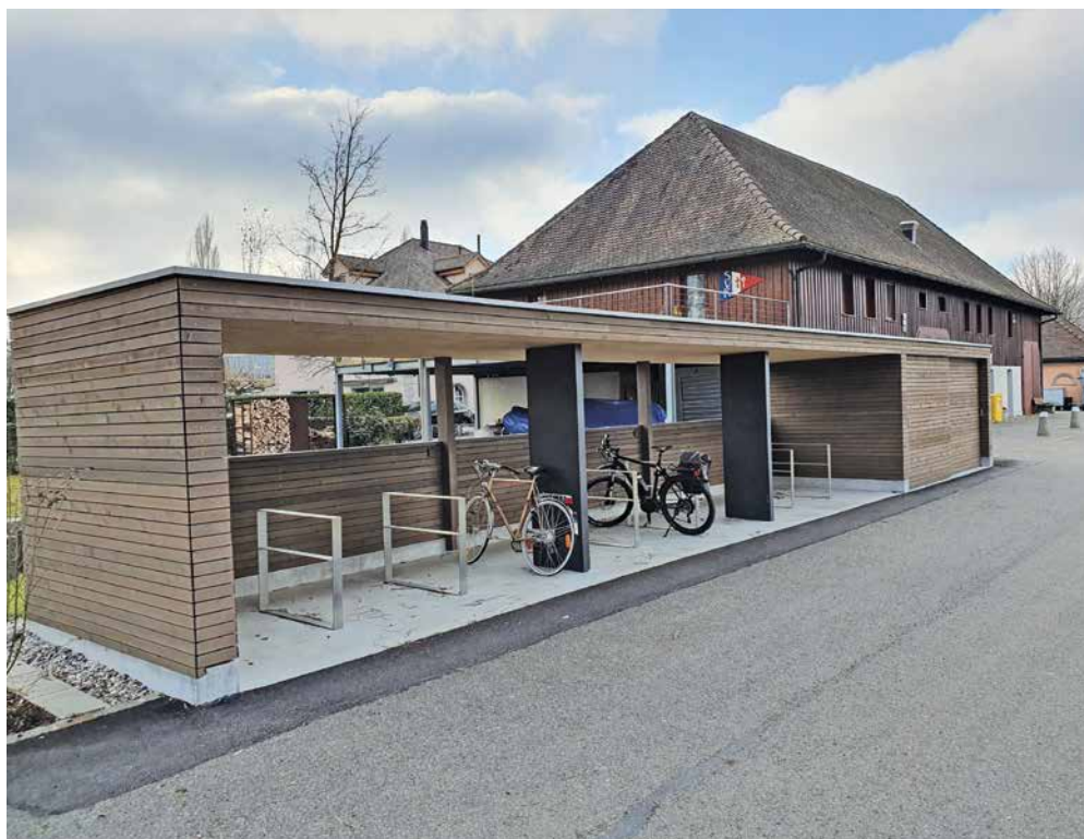
Neue Veloabstellanlage beim Yachthafen Seegarten.
