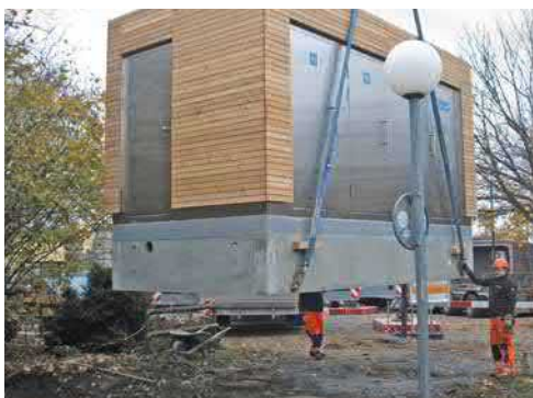
WC-Anlage beim Spielplatz Seeburgpark.
