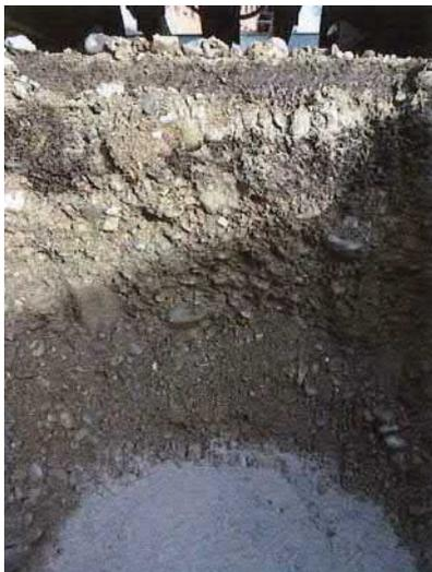
Mit drei Sondagen wurden am 12. Dezember 2019 durch das Prüflabor der bestehende Oberbau und das Planum untersucht (Auftrags-Nr.: 19-200643).
