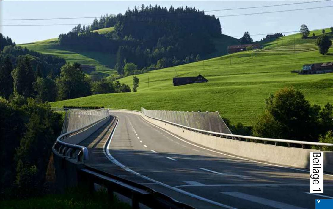
■ Taminabrücke, Pfäfers-Valens (CH): leichte vertikale Schutzvorrichtung,
