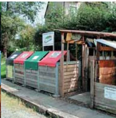
Decotherm-Anlage mit Geräteunterstand und Häckselbehälter
