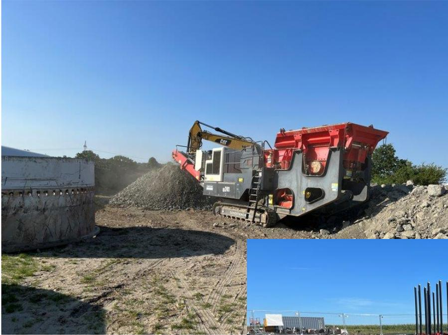
Shreddern des alten Beton-Fundamentes
