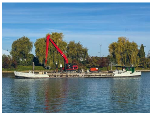
Ausbaggerungsarbeiten im Kursschiffhafen.
