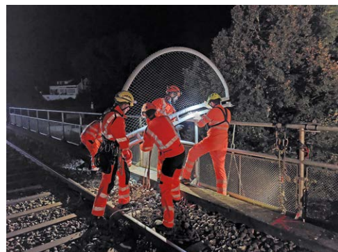
Montage Suizidschutz am Viadukt Sauloch.
