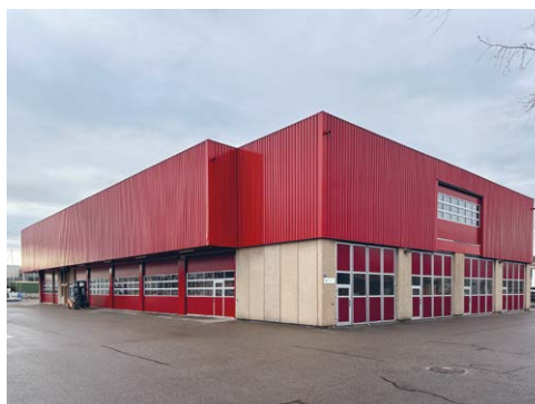
Die neuen Rolltore und das sanierte Dach des Werkhofs.
