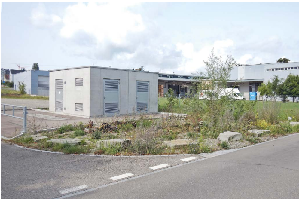
Naturnahe Aufwertung von öffentlichen Restflächen in der Umgebung der Trafostation Promenadenstrasse.
