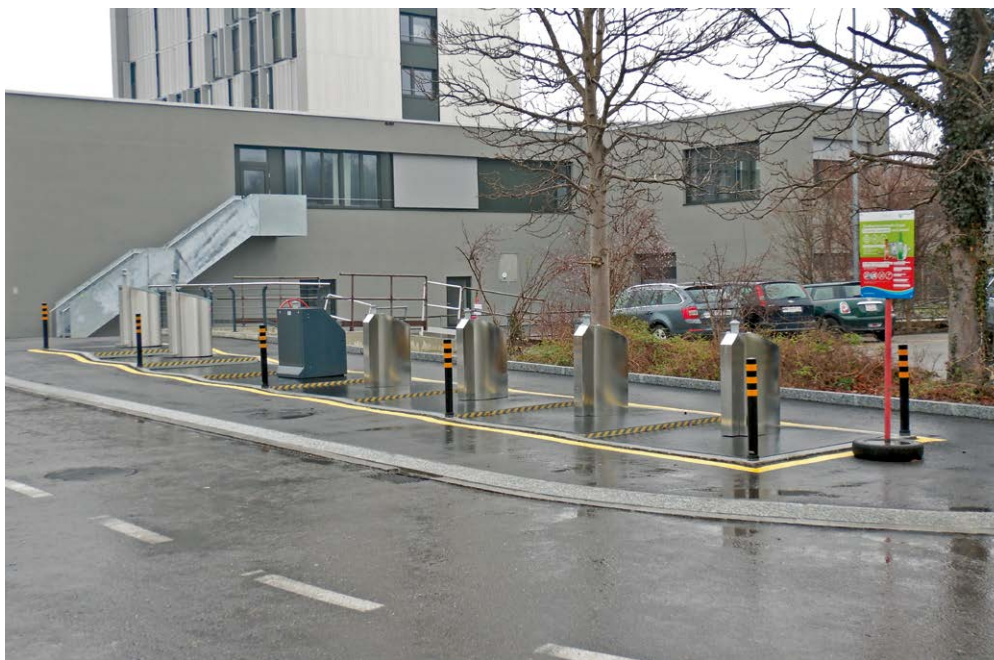
Sammelstelle «Brückenstrasse» nach dem Neubau der Brücke über den Schoderbach.
