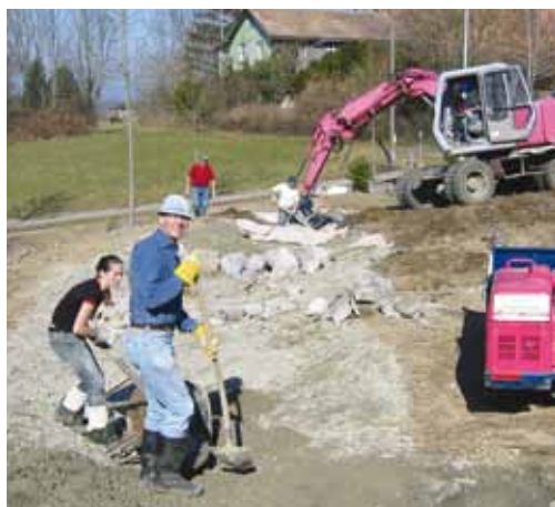
Bauarbeiten Umgehungsgerinne Sägenösch, Krebsbach.
