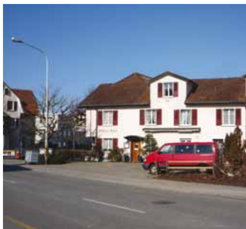
Bachstrasse 2010, der Schoderbach verläuft hier eingedolt (links).
