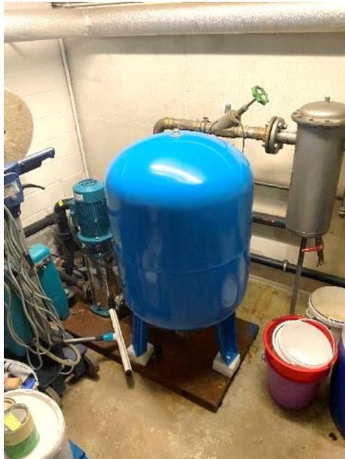
Abb. 56, Druckerhöhung Zamboni-Anlage
