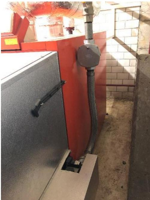
Abb. 1, Gaskessel mit Gasanschluss
