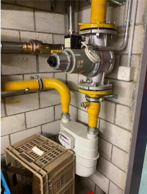
Abb. 53, Werkseitiger Gaszähler
