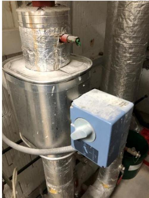
Abb. 25, Stellantrieb Regelventil
