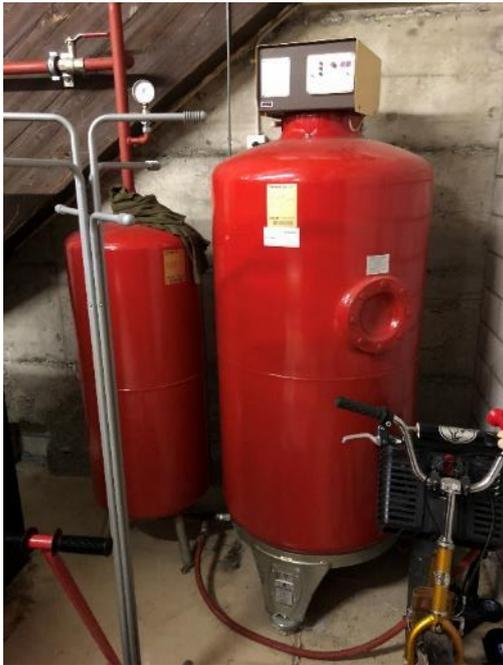
Abb. 3, Expansionsanlage Heizung
