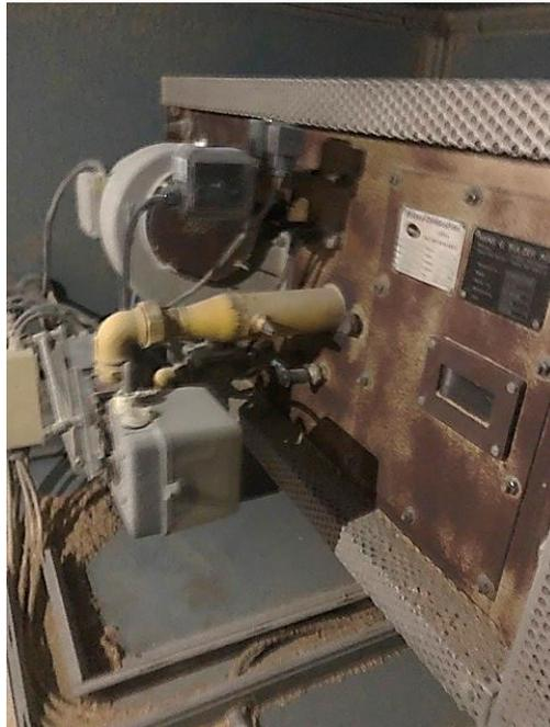
**Abb. 34, Gasbrenner L-Gerät Eishalle**
