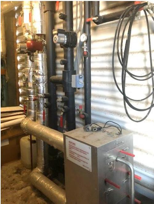
**Abb. 28, Systemtrennung L-Gerät Stadion**
