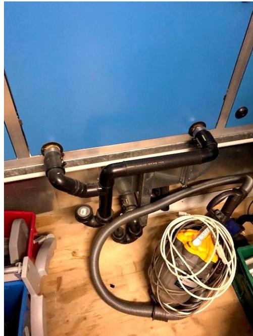
Abb. 44, Kondensatabläufe L-Gerät
