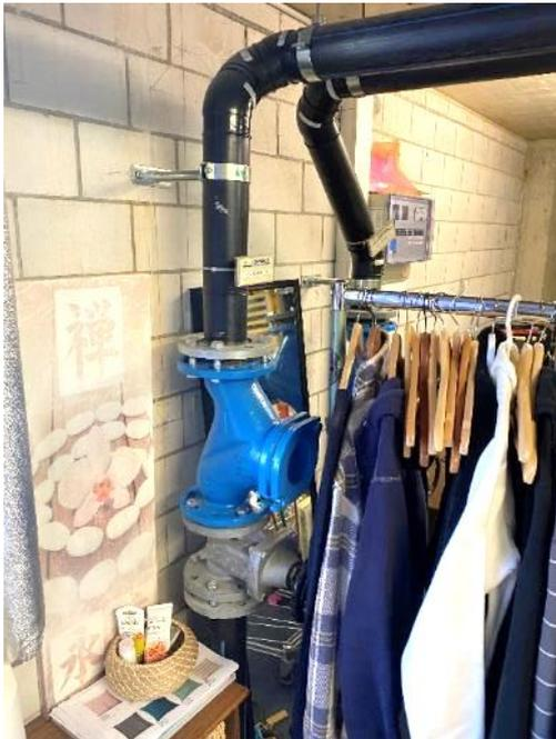
Abb. 51, Pumpendruckleitung
