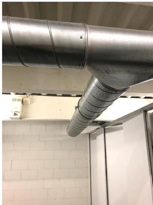
Abb. 42, Rohrinstallationen Abluft
