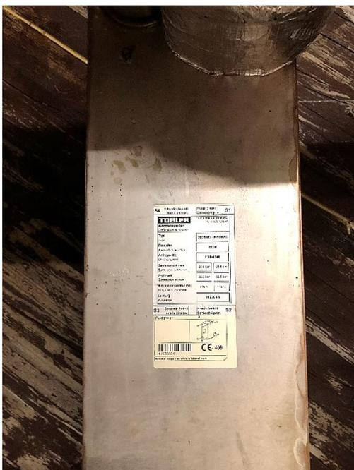
Abb. 13, Wärmetauscher WRG - Fernleitung
