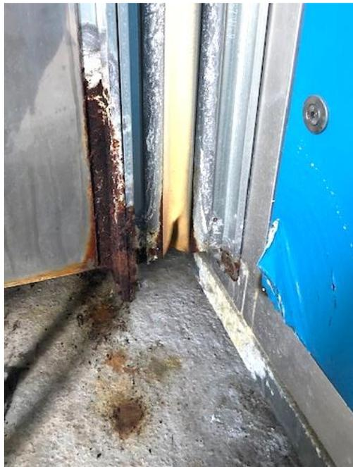
**Abb. 36, Kanalanschluss L-Gerät Eishalle**
