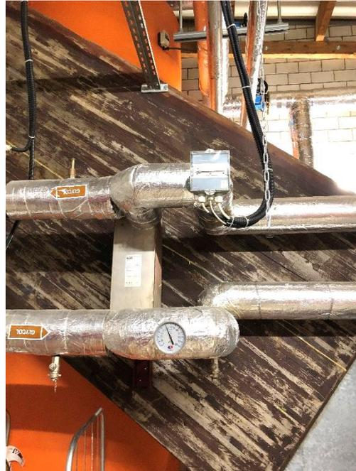
Abb. 12, Systemtrennung WRG Kältemaschine
