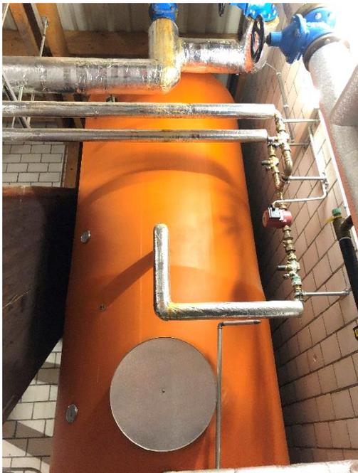
**Abb. 9, Brauchwassererwärmer**
