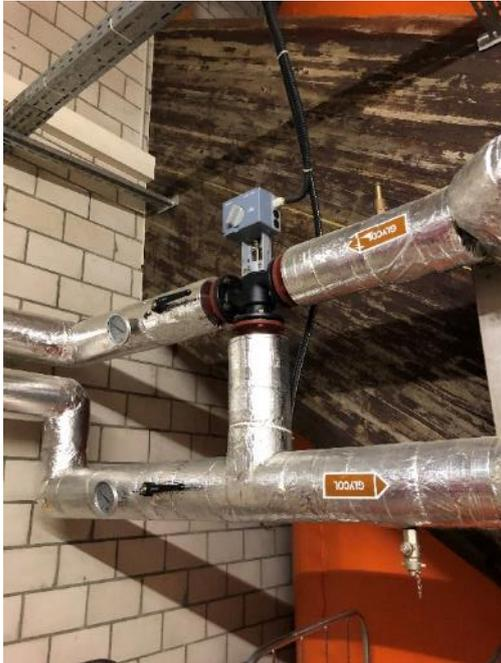
Abb. 11, WRG Kältemaschine
