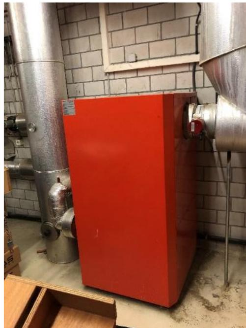
Abb. 2, Abgas Wärmerückgewinnung (WRG)
