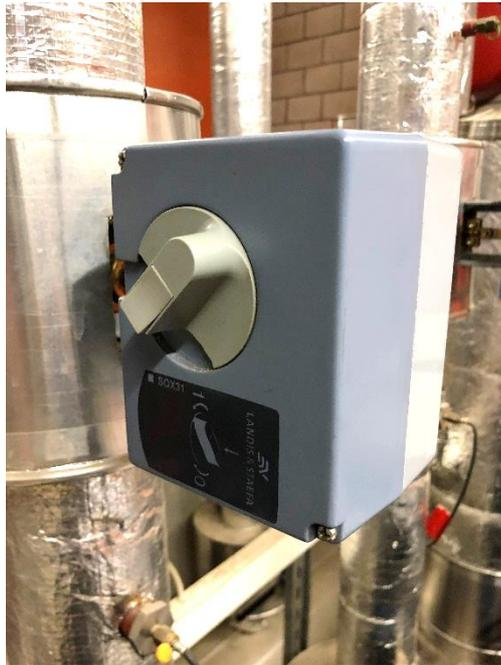
**Abb. 8, Stellantrieb Regelventil**
